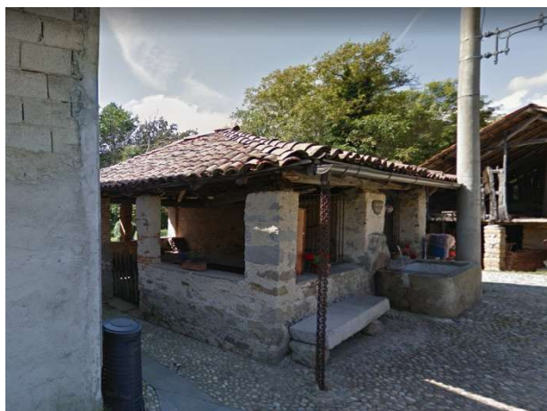
Figura 14: Lato Sud e Lato Est
