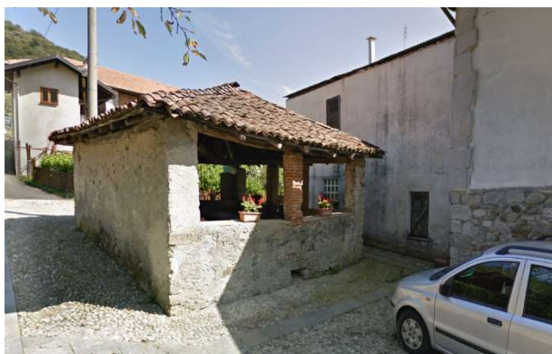
Figura 15: Lato Ovest e Lato Nord
