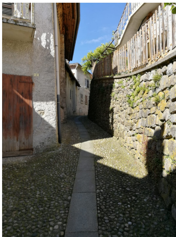
Figura 20: particolare muri a secco e pavimentazione in acciottolato
