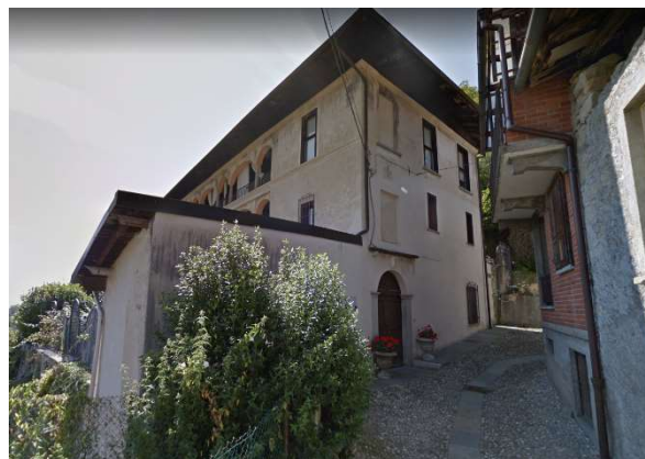
Figura 24: Particolari edifici in Via Circonvallazione
